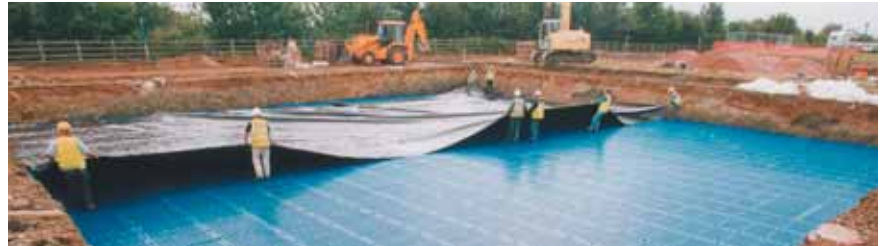
Fig. 34 Positioning the top layer geomembrane (or geotextile) wrap
